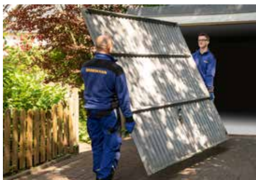
Ausbau und umweltgerechte Entsorgung
